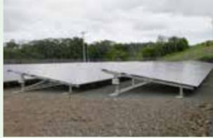
**Instalación Fotovoltaica con Balance Neto de 255 Kwp de potencia instalada (200 Kw Nominales) instalada sobre cubierta y marquesinas aparcamiento en La Casa del Jamón, ubicada en Costa del Este de Panamá City**
