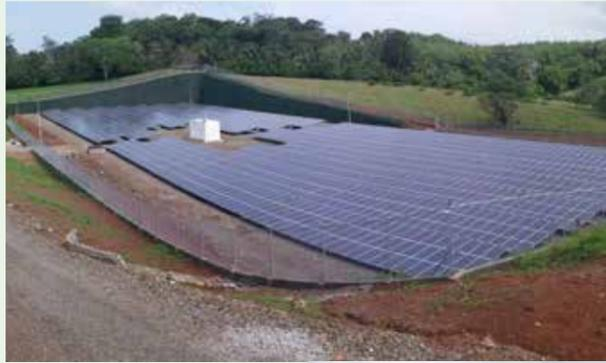
**Instalación Fotovoltaica con Balance Neto de 600 Kwp de potencia instalada (500 Kw Nominales) instalada sobre suelo en Finca Edanjo. La Chorrera, Panamá**
